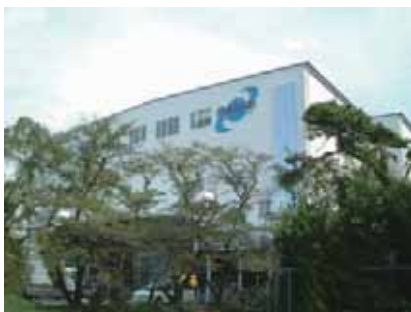
■丸栄工業株式会社 本社 ロジスティックセンター
